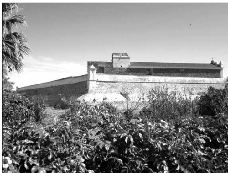
Fig. 10: Baluarte de San Juan de Dios (Foto F. Lavado Rodríguez).
