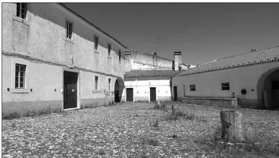
Fig. 27. Quartel dos Telheiros
