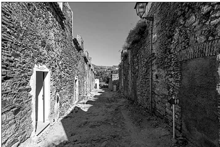
Fig. 12. Rua dos Quartéis
