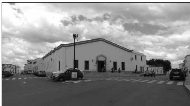
Fig. 17. Quartel de S. Carlos (Armazém de palha)
